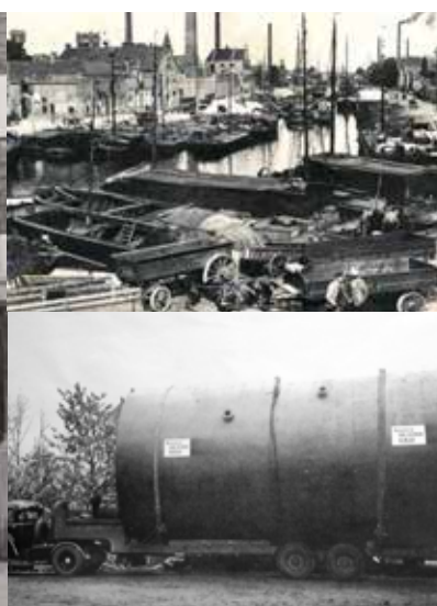
Tank van waterzuiveringsbedrijf Rossmark uit Almelo op door Sluis of Boom gebouwde trailer.
